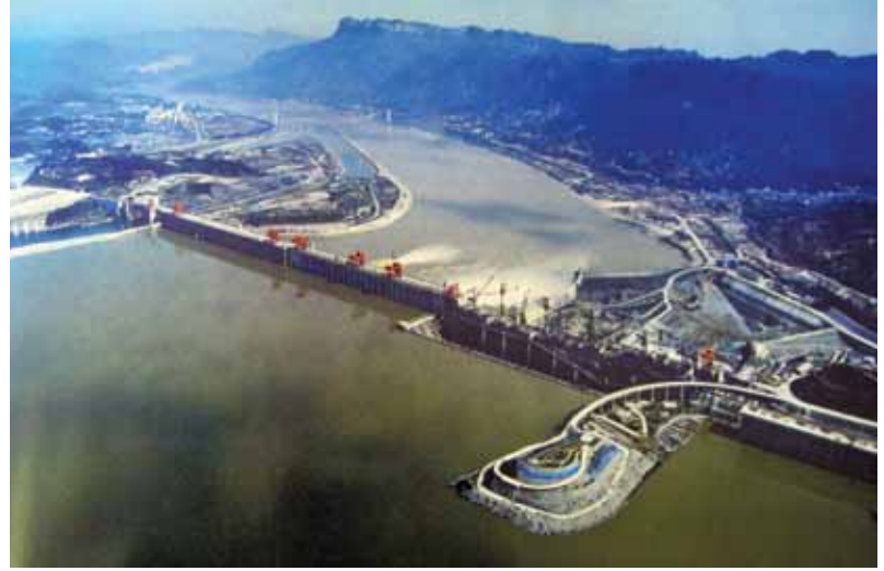
Üç Boğaz Barajı
