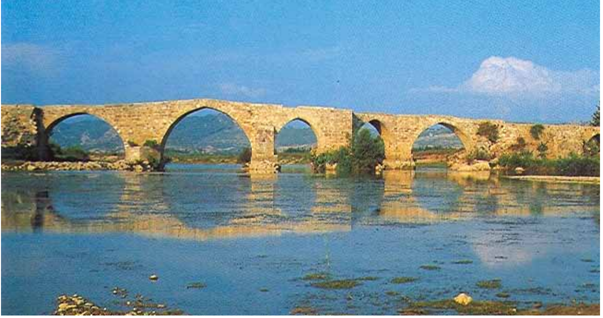
Aspendos Selçuklu Köprüsü, Aspendos Seljuk Bridge
