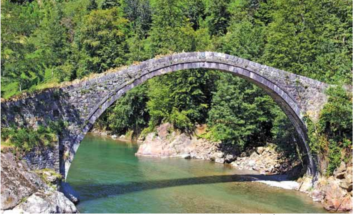
Fırtına Deresi Taş Köprü. Fotoğraf: İsmet Öztürk / The Firtina Brook Stone Bridge.
